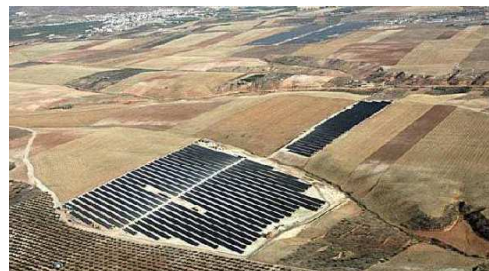
Darro, Spanien Installation einer 5,9 MWp Freiflächenanlage für Beck Energy (17 ha)
